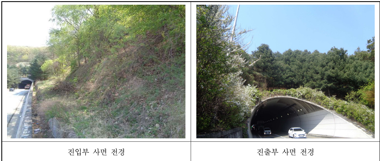
【사진 3.9】 사면 진·출입부 전경
