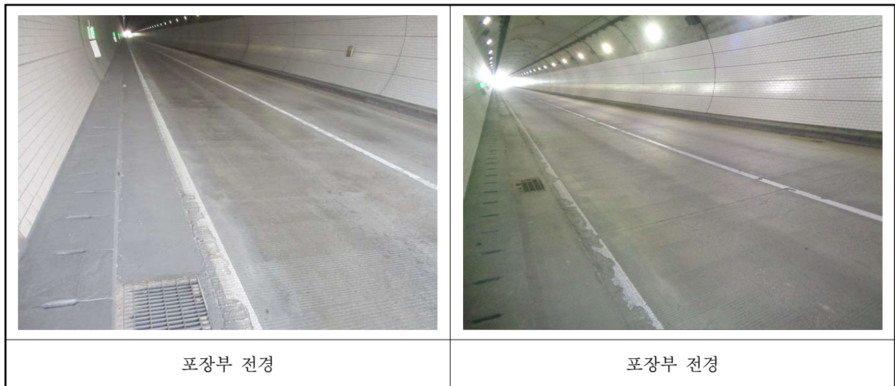
【사진 3.13】 터널 포장부 전경
