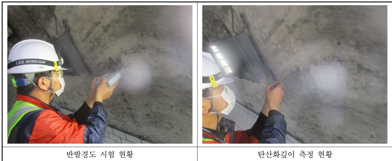
【사진 3.17】 콘크리트 내구성조사 현황
