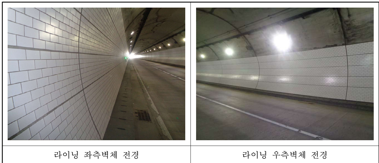
【사진 3.5】 터널 라이닝 측벽부 전경
