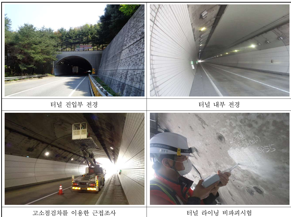
【사진 3.2】 근접조사를 위한 장비 사용 전경
